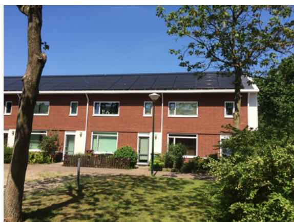
Voorbeeld Soesterberg: 109 NOM woningen van Portaal zien er weer uit als nieuw.
