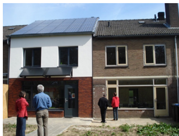
Voorbeeld Arnhem: NOM-proefwoning met een dak dat volledig uit zonnepanelen bestaat en waarbij een zonnecollector voor warm water als vaste zonwering boven het grote raam (op het zuiden) is toegepast.
